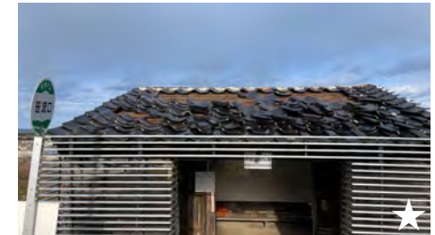
▲ 笹波口バス停 バス停建物破損 屋根瓦落下、ずれ
