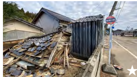
▲ 川尻バス停 バス停建物破損(隣家倒壊) 屋根瓦落下・ずれ 外側造形物の湾曲
