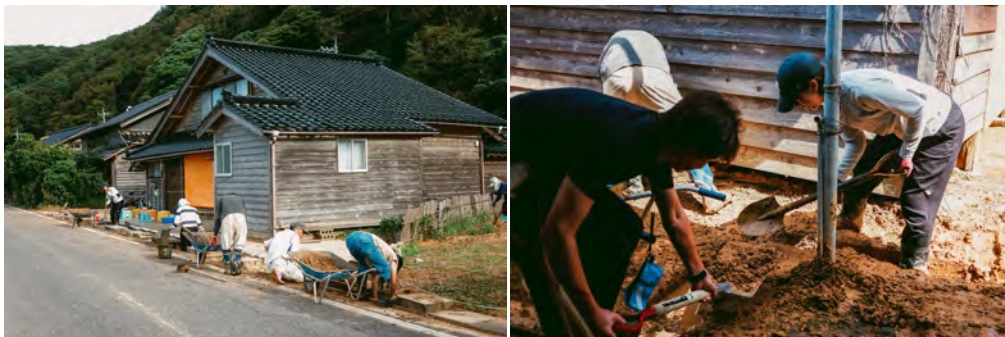
豪雨により流入した土砂の掻き出し作業
